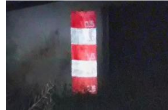
図3 蛍光反射塗料塗装例(夜間)
