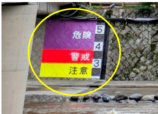
玖珠川 天瀬橋に設置された水位ライン(大分県) (大分県土木建築部河川課)
