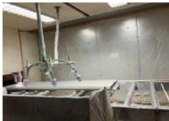
写真1 下塗塗料の塗装状況 (ECP 工場塗装)
