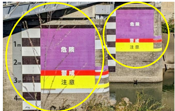
菊川 加茂橋に設置された水位ライン(静岡県) (国土交通省中部地方整備局浜松河川国道事務所)
