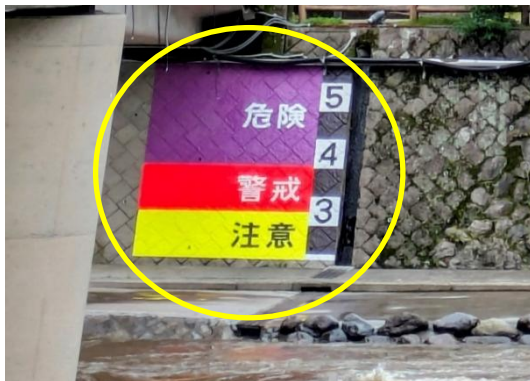
玖珠川 天瀬橋に設置された水位ライン(大分県) (大分県土木建築部河川課)
