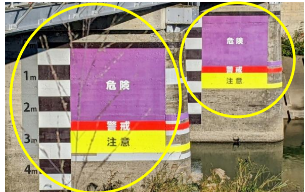
菊川 加茂橋に設置された水位ライン(静岡県) (国土交通省中部地方整備局浜松河川国道事務所)
