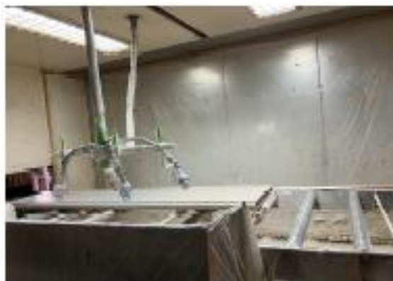
写真1 下塗塗料の塗装状況 (ECP 工場塗装)
