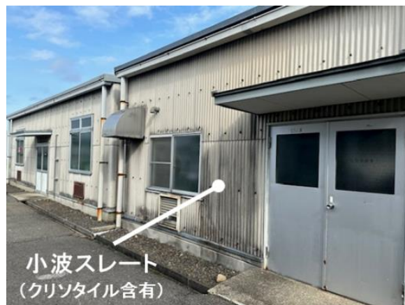
図3 当社那須事業所における試験棟の外観
