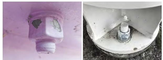
図2 溶融亜鉛めっき高力ボルトのナット部における塗膜はく離事例
