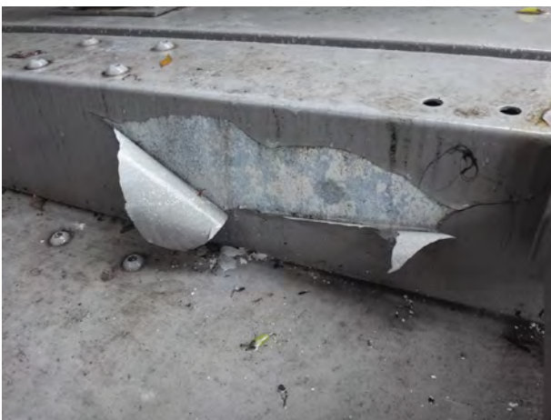
図1 溶融亜鉛めっきにおける塗膜はく離事例
