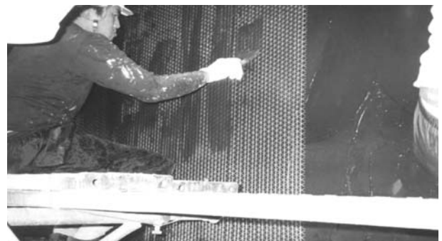
写真3 ピニロンメッシュシート貼付け工程
