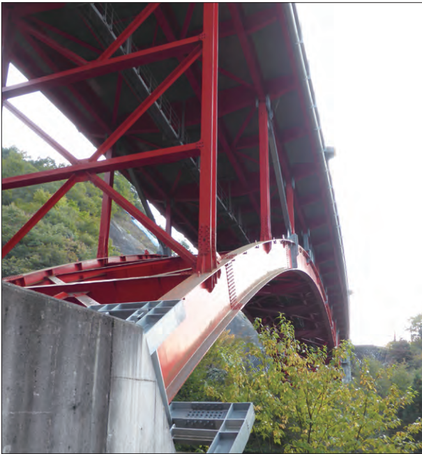
写真1 塗装後28年経過したふっ素樹脂塗装
