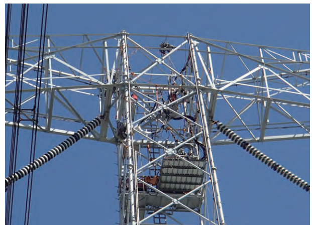
写真1 対策工事实施状況
