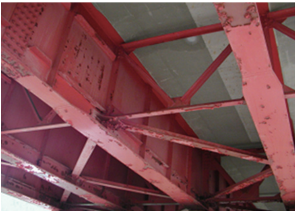
写真2 塗装後16年経過したフタル酸樹脂塗装
