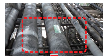
保温材下の腐食事例
