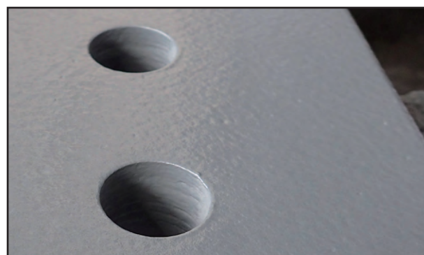
図14 実施工板の外観
