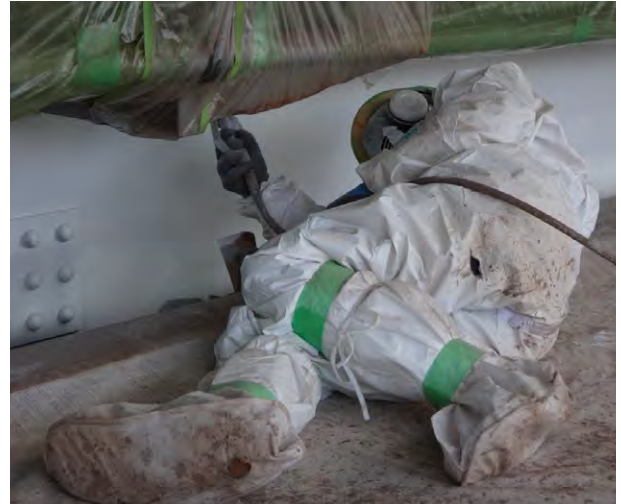
図14 水性エポニックス中塗塗装
