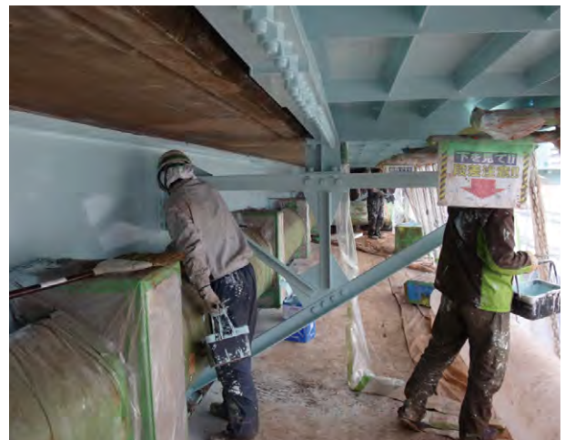
図15 水性Vフロン#100H上塗塗装
