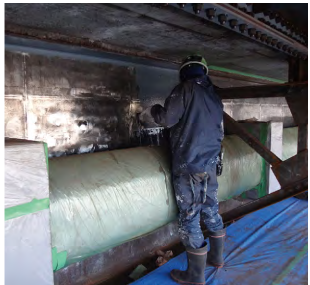
図10 水性ゼッターールEP-2HB塗装
