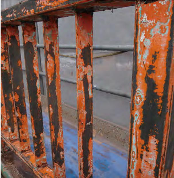
図8 残存した鉛丹ペイント
