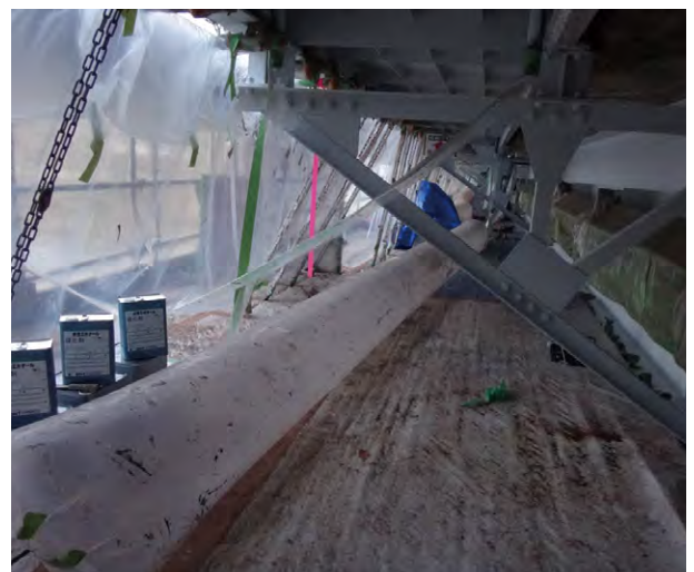
図20 ビニールダクト設置状況
