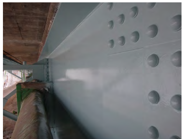
図16 上塗塗装完了
