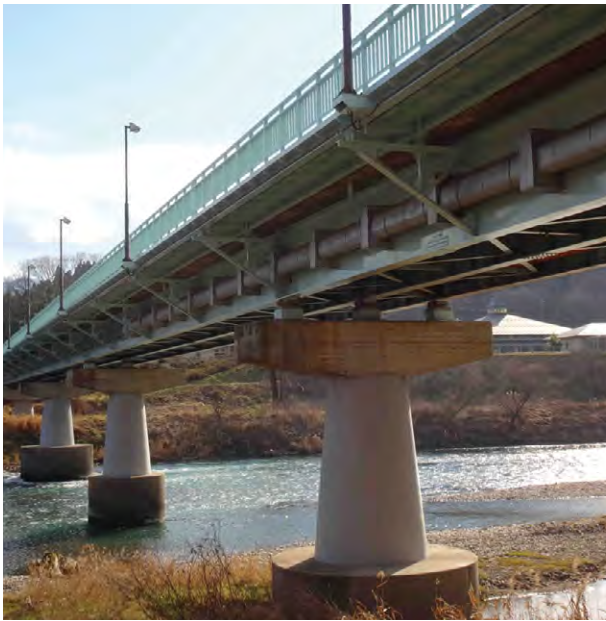
図23 「DNT水性重防食システム」で塗り替えた大原橋
