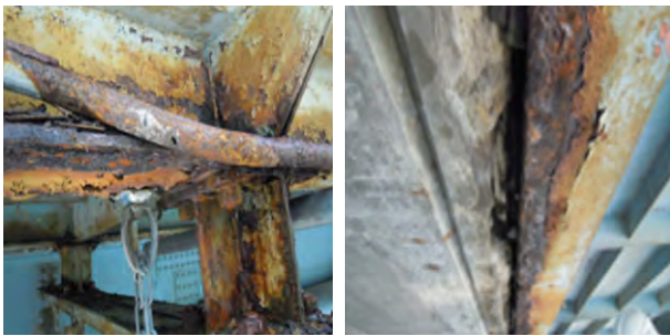
図5 腐食の著しい部分
