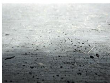
コンクリートの表面状況例
