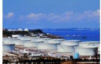
沖縄石油備蓄基地
