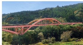
【里美大橋(茨城):塗り替え前】
