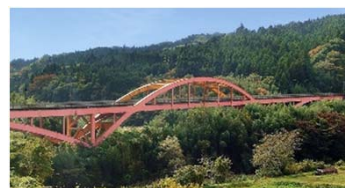
【里美大橋(茨城):塗り替え前】
