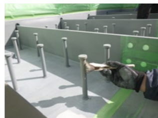
3. 狭隙部など膜厚の付きにくい箇所に先行塗装
