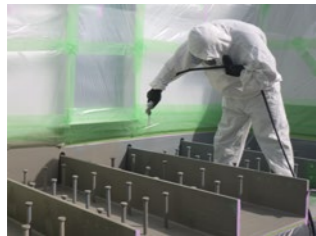
4. 全面へエアレススプレーにより塗装
