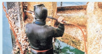
エア工具による海生物と浮きさびの除去作業
