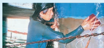
海生物などを除去するため、マジックロン処理を行い、清浄にする。
