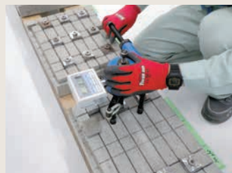
建築研究所方式試験状況
