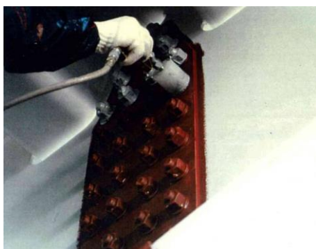
カップ塗装作業状況
