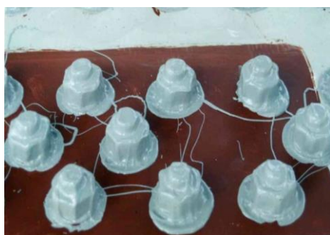
カップ注入塗装後、余分な塗料は刷毛で均し塗装する。
