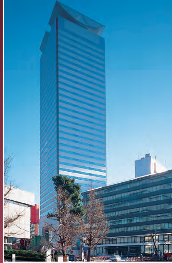
住友不動産虎ノ門タワー (東京)
