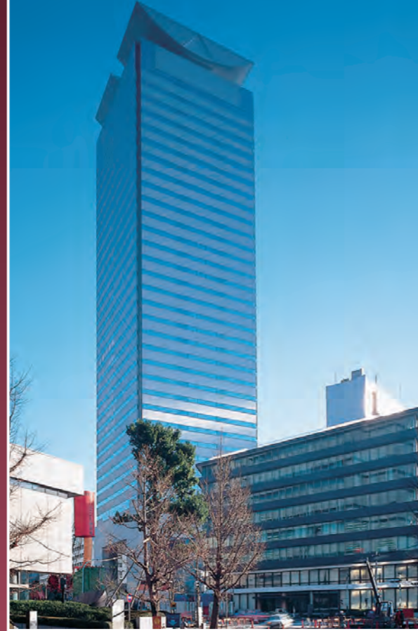
住友不動産虎ノ門タワー (東京)
