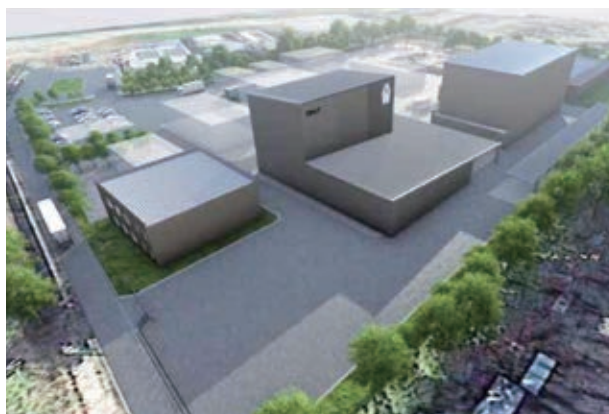
建設中の物流・生産拠点（滋賀県湖南市）
