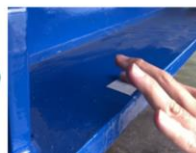
メタモルシート#1を貼付け
