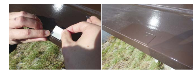
さびを落としてシートを貼り、上塗り塗装するだけ。 手軽に施工でき、長期耐久性が見込めます。
