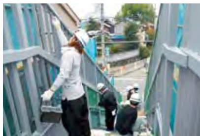
学生による歩道橋塗装作業風景
