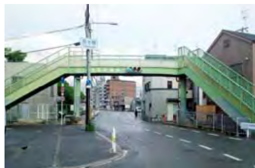
【塗り替え前】北宮歩道橋
