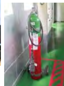
消火器の設置
