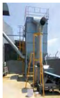
排気システム
