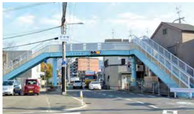
【塗り替え後】北宮歩道橋
