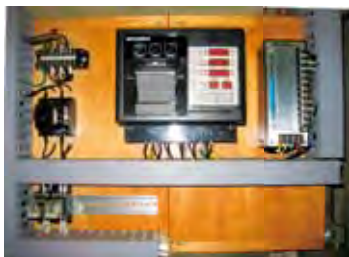
デマンド監視システム
