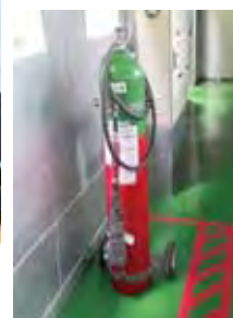
消火器の設置
