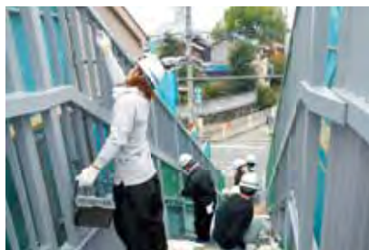
学生による歩道橋塗装作業風景
