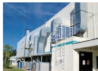
排気システムの設置
