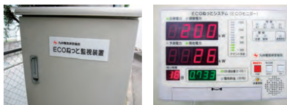
電力デマンド監視システム
