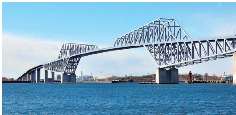
東京ゲートブリッジ
