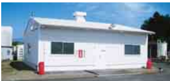
工場内遮熱塗料の施工例
