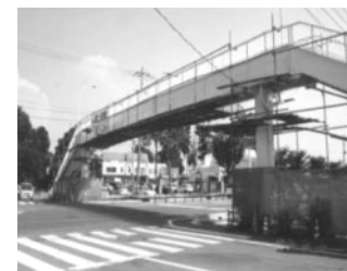
写真4 鋼製歩道橋における施工例
