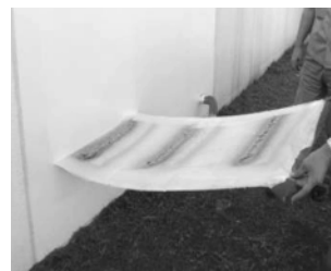
写真3 ストリップペイントによる 落書き除去
