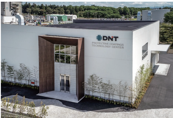
図1 防食技術センター外観
