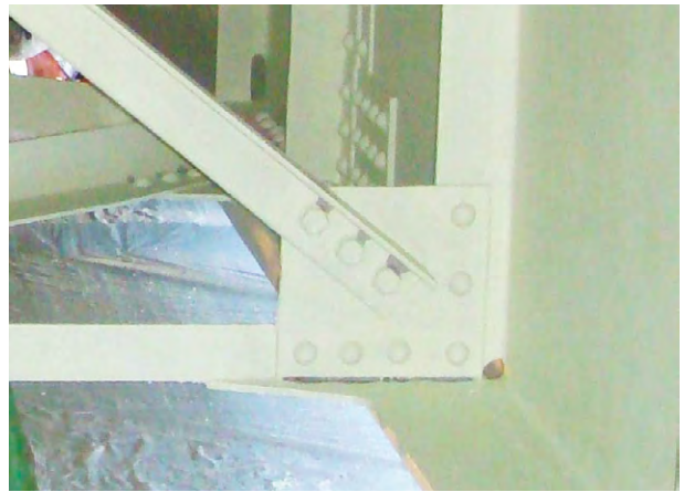
図9 塗膜厚の測定対象部材
