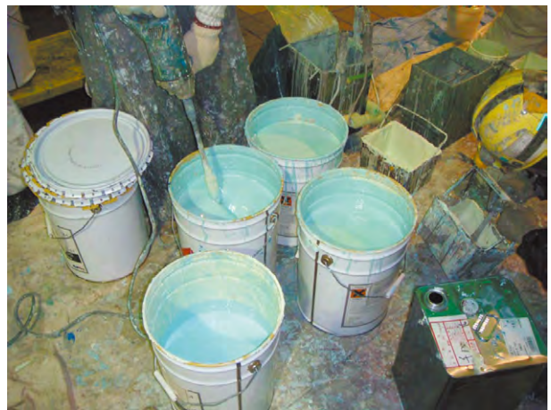
図4 塗装現場での着色作業
