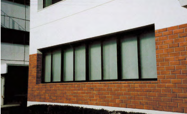
図1 コンクリート壁面 レンガ塗装(シンロイヒ(株)構内) 使用されている技法:エイジング、フォー・フィニッシュ
