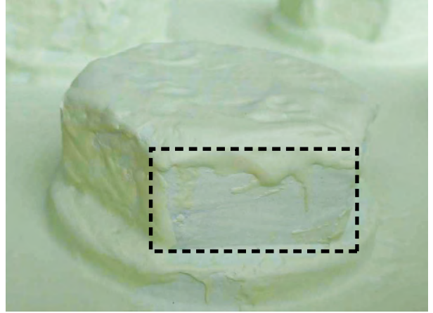
図8 微黄色に着色した耐火塗料の塗り漏れ
