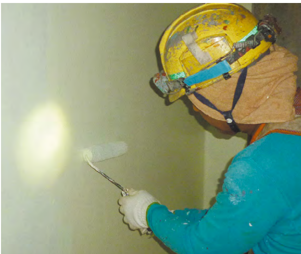
図1 耐火塗料の塗装状況
