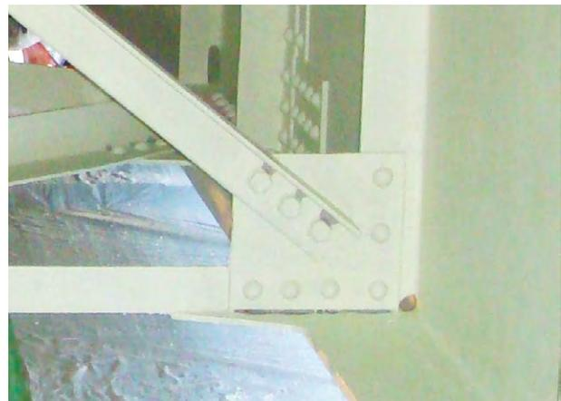
図9 塗膜厚の測定対象部材
