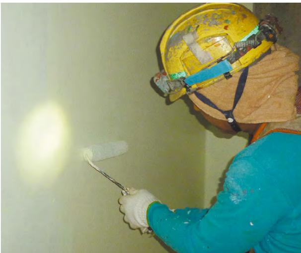
図1 耐火塗料の塗装状況
