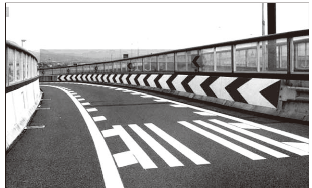
図1 ビームライト施工実績例
