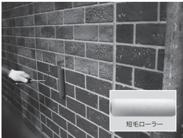
図11 カラークリヤー塗装工具と施工例
