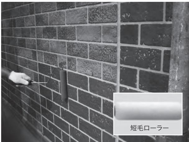
図11 カラークリヤー塗装工具と施工例
