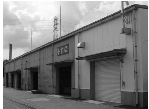
写真2 大日本塗料(株)那須工場内倉庫での性能比較実験状況
