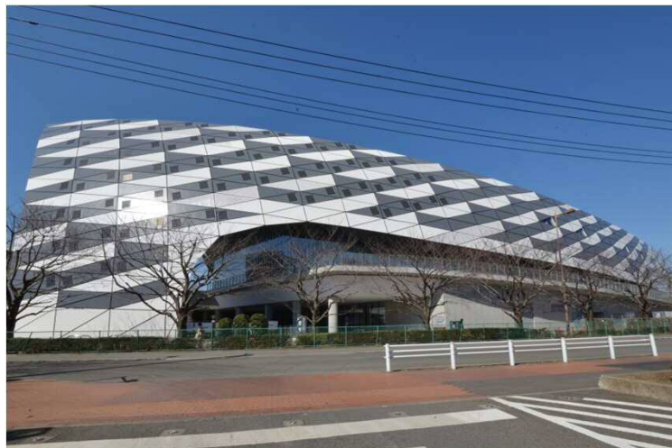
武蔵野の森総合スポーツ施設「メインアリーナ」 耐候性に優れた「パウダーフロンCW」が採用
