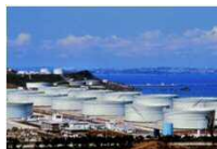
沖縄石油備蓄基地
