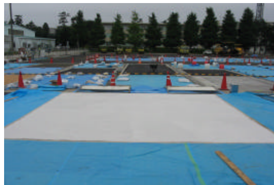
写真4 骨材散布後の状況
