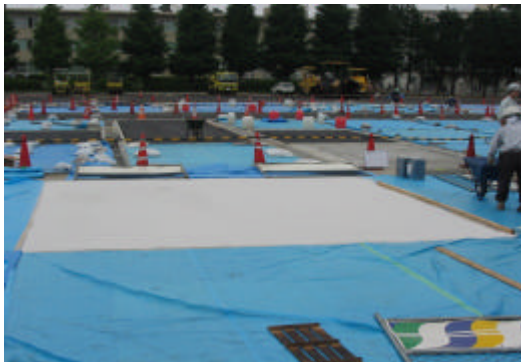
写真3 下塗り塗装後の状況
