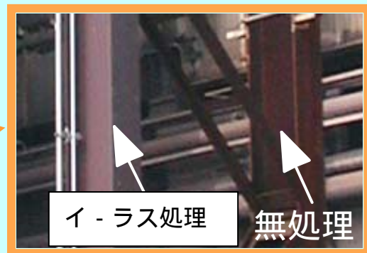
屋外クレーン支柱 (1年6ヶ月後)
