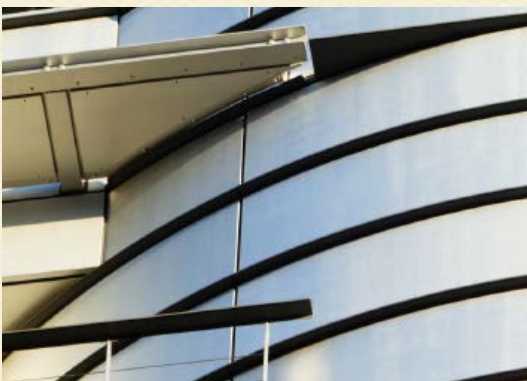
都内商業施設の施工後
