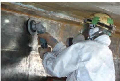
素地調整による鋼材露出
