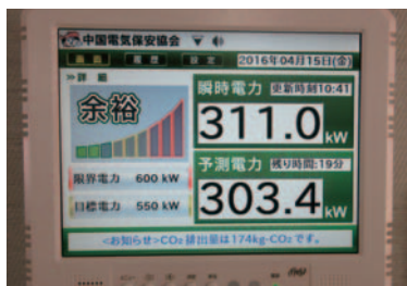
電力デマンド監視システム
