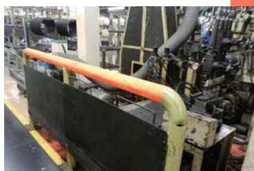
工場内防護パイプの視認性向上
