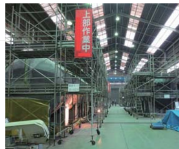
地下埋設燃料タンク外面塗装風景
