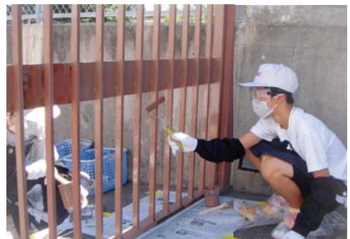
水性塗料の塗装実習
