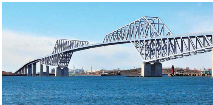
東京ゲートブリッジ
