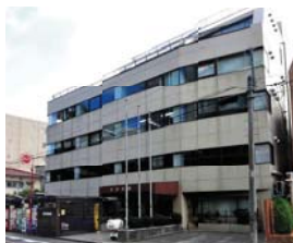
「塗装会館」改修前
