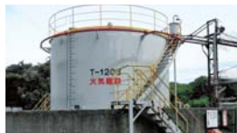
屋外タンク補修
