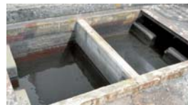
油水分離槽整備
