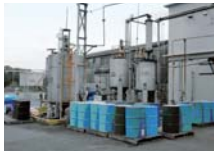
溶剤回収設備
